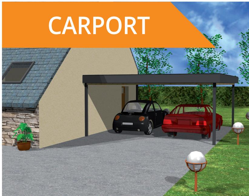
Le terme carport vient de l'anglais : étymologiquement un carport est un emplacement de stationnement pour voiture sous une structure simple, légère et solide servant à protéger les véhicules des aléas climatiques en toutes saisons.
